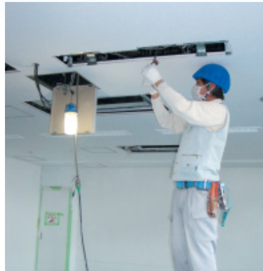
照明器具取付作業
